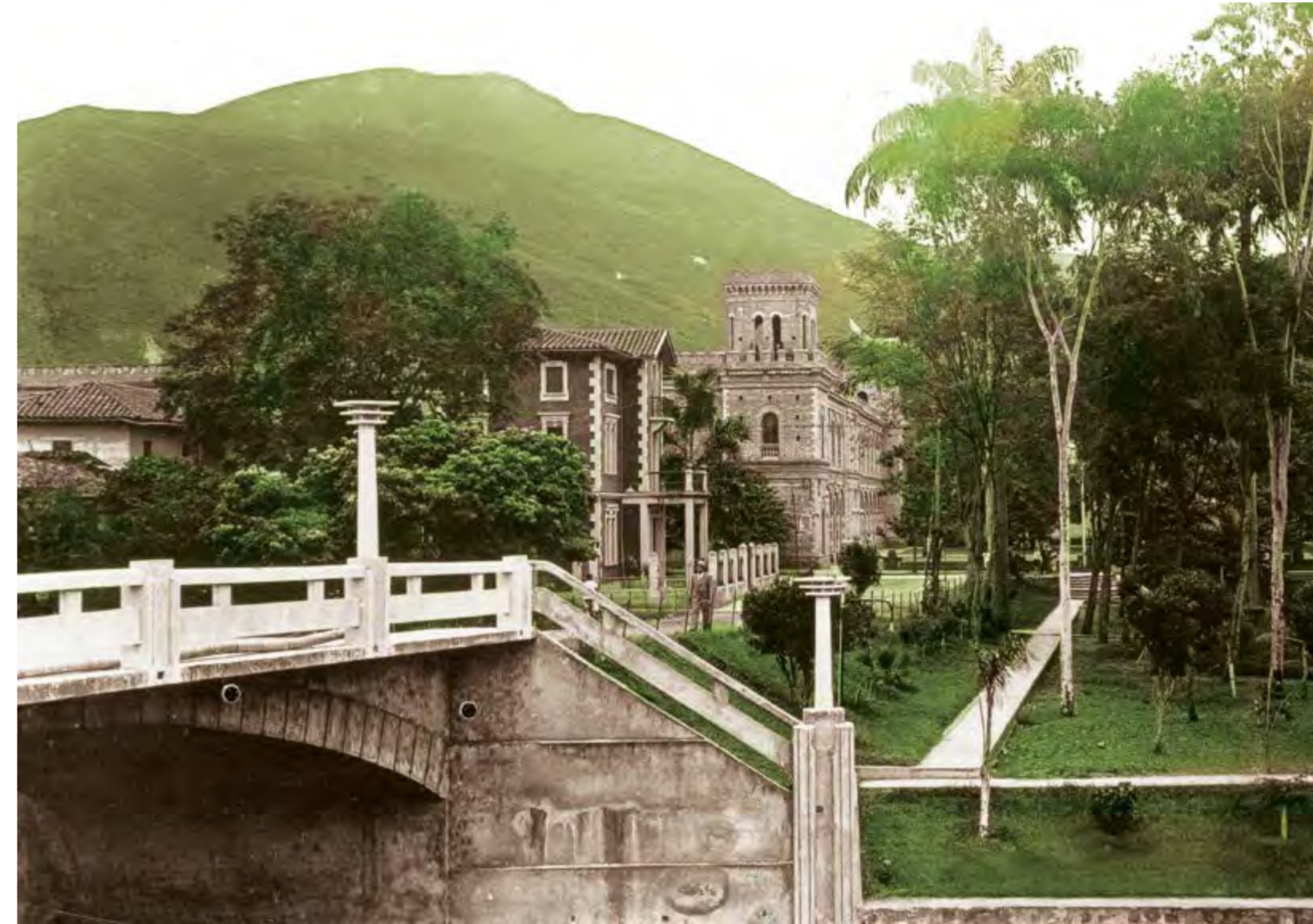
Puente España pasando la Calle once
