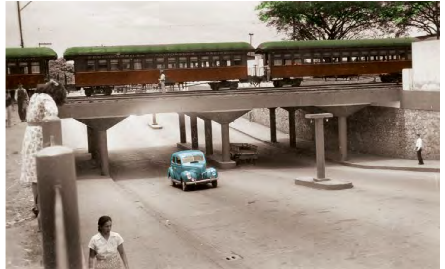
▲ Paso a nivel del Ferrocarril sobre la carrera quinta con calle 25.
