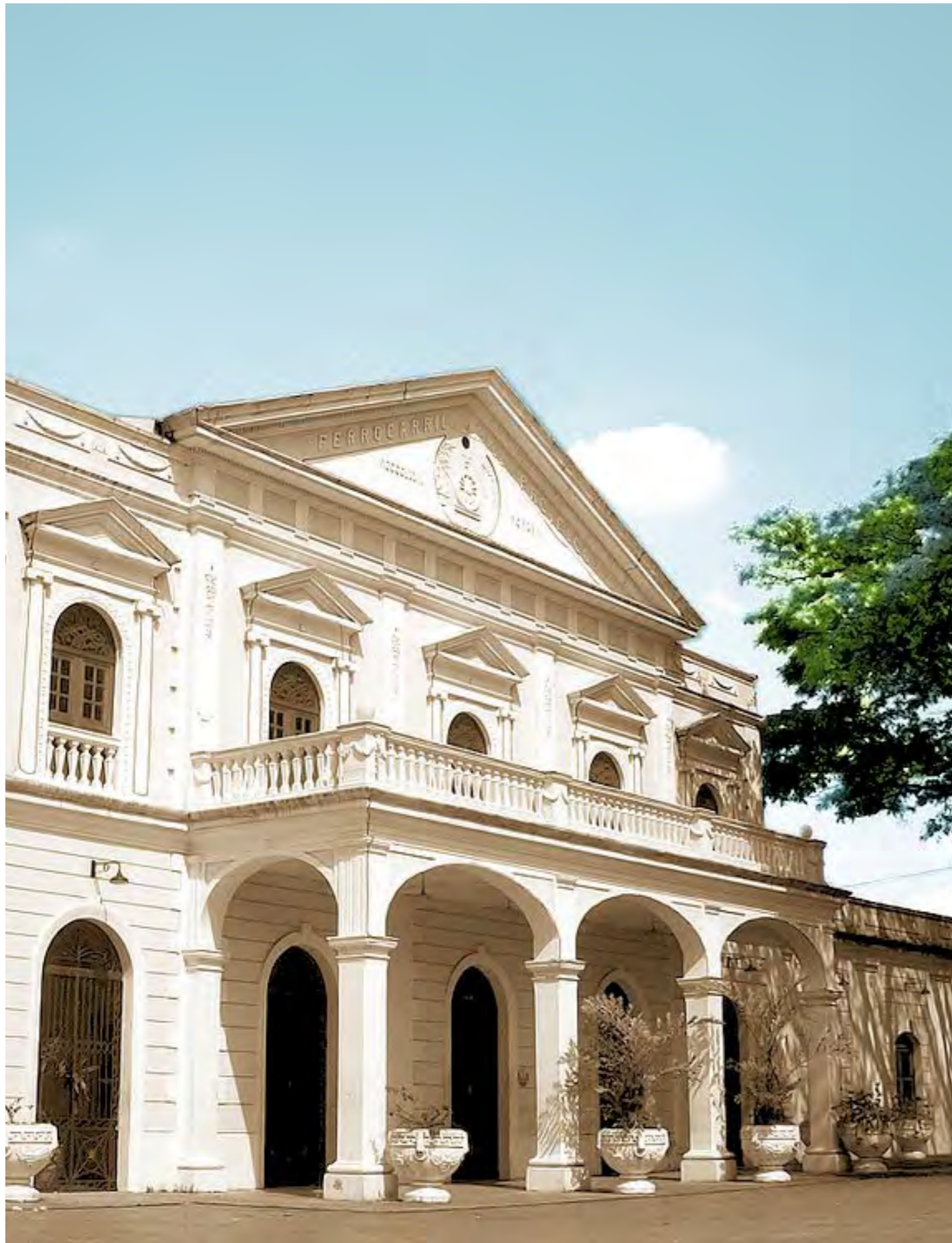
▲ Palmira, Estación del Ferrocarril.
