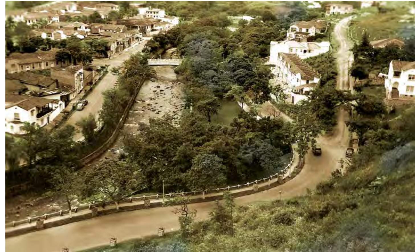
Vista de los barrios El Peñón y Normandía. Al fondo, el puente que los comunica. ▲
